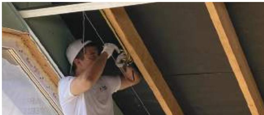
**3.8.** После монтажа крайних подвесов на всех наклонных и горизонтальных участках утепляемой кровли демонтируйте потолочный профиль легким отгибанием его полки в местах крепления к подвесу. Для облегчения демонтажа поверните подвес внутри профиля на небольшой угол.
