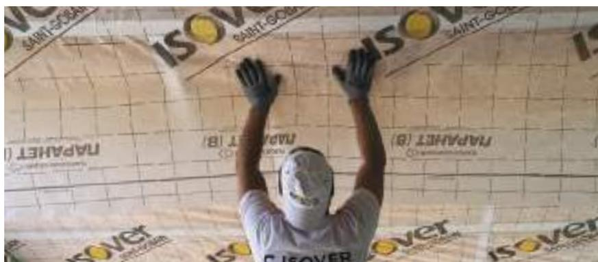
**7.5.** Склейте полотна пароизоляции между собой лентой Изовер Паранет или двусторонней лентой Изовер Паранет ДУО, проклеивая ее внутри между слоями пароизоляции.
