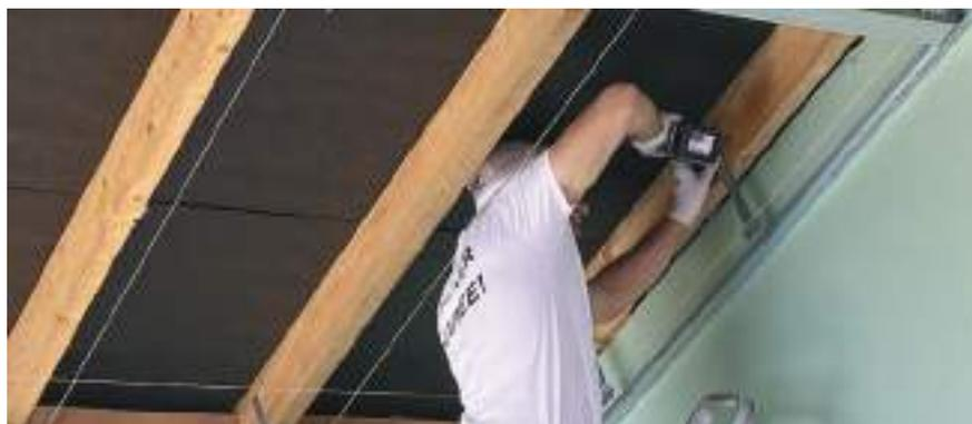
**3.11.** На каждой отметке закрепите подвес через овальное отверстие, предварительно выровнявая его положение по нити, параллельной стропиле, и соблюдая его перпендикулярность при помощи угольника. После выравнивания положения и угла закрепите все подвесы на второй саморез.
