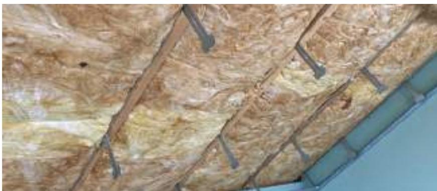
**4.3.** Аналогичным образом разрежьте пополам рулоны утеплителя для перекрестного (горизонтального) слоя теплоизоляции.
