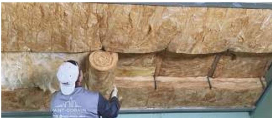
**4.5.** В местах, где остаются узкие участки под утепление (где начинается и заканчивается скат крыши и на других участках, не кратных 60 см), смонтируйте утеплитель, предварительно отрезанный по ширине, превышающей данные участки на 1 см. В наклонных участках обрезайте утеплитель по всей длине под углом, примерно равным углу ската.
