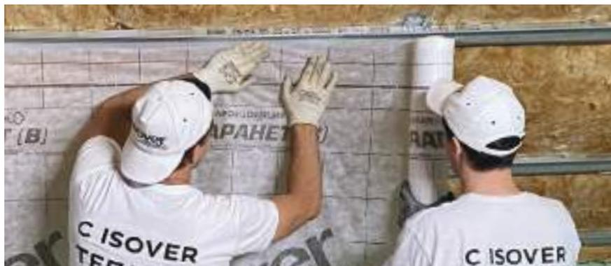
**7.4.** Повторите монтаж следующих полотен по всей утепляемой кровле с соблюдением нахлеста между полотнами и припуска по 1 см на левую и правую стороны.
