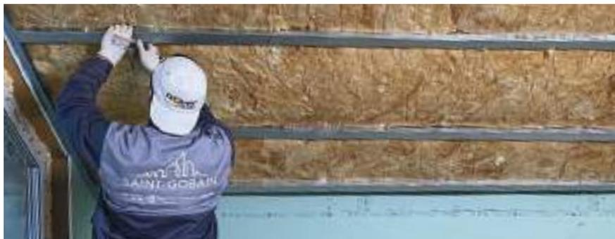
5.4. Проверьте все соединения потолочных профилей с подвесами. Для ускорения проверки воспользуйтесь правилом. Не должно быть профилей, развернутых под углом к общей плоскости.
