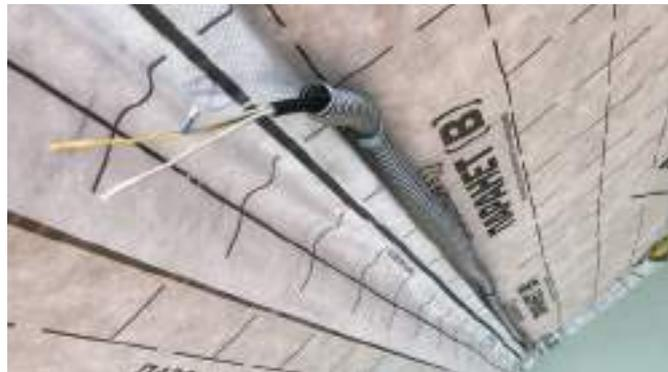
**7.7.** При помощи герметика vetonit hybrid universal обработайте стыки полотен с фронтонами, отогнув край пароизоляции перед нанесением, а после герметизации прогладьте стык пароизоляции для лучшей склейки поверхностей.
