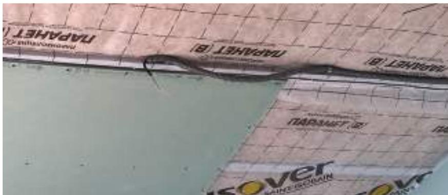
**8.3.** Закрепите плиты по всему периметру к профилю саморезами по металлу с шагом крепежа не более 25 см согласно разметке на листе.
